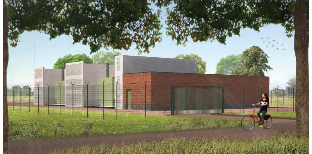
^ In fase 1 en 2 worden onderdelen van het huidige station vervangen en wordt de capaciteit van het station vergroot door middel van extra transformatoren en gebouwen met installaties. Bovenstaand beeld geeft niet de specifieke situatie in Bommel weer maar geeft wel een impressie van transformatoren in open boxen (links) en een gesloten gebouw met installaties (rechts).
