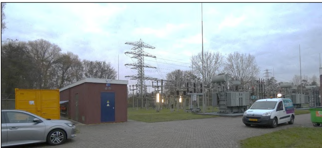
Figuur 3: Het bijgebouw en de schakeltuin.
