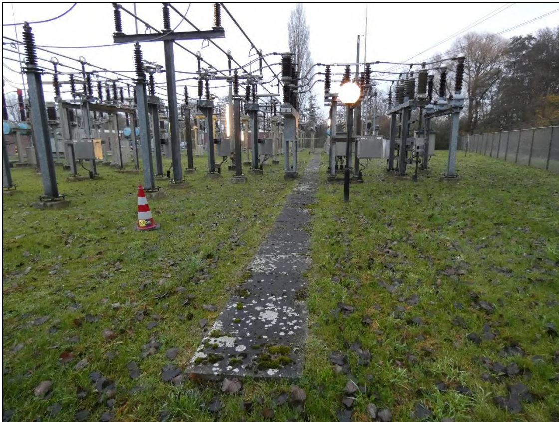
Figuur 13: Verharde paden in de schakelstation.
