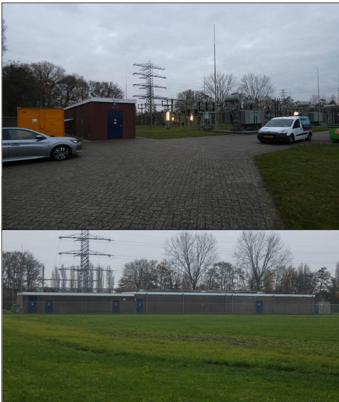
Figuur 2: Het plangebied bestaat uit het reeds bestaande transformatorstation met schakeltuin en een aanliggend perceel grasland waarop de uitbreiding zal gerealiseerd worden.
