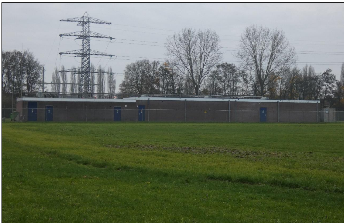
Figuur 12: Het graslandperceel waarop de uitbreiding in fase 1 en 2 zal worden gerealiseerd. Achteraan is het huidige transformatorstation te zien.
