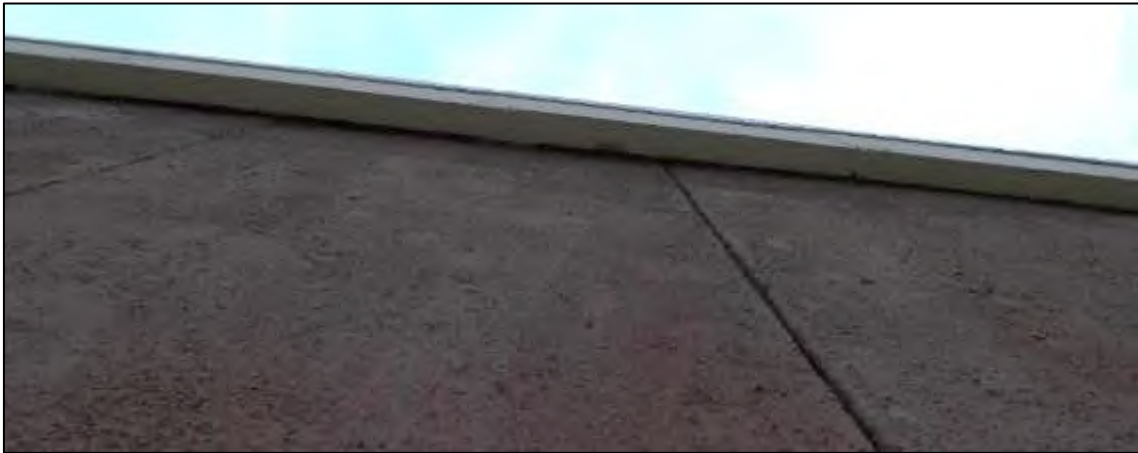
Figuur 11: Verticale voegen en dakrand van het bijgebouw.
