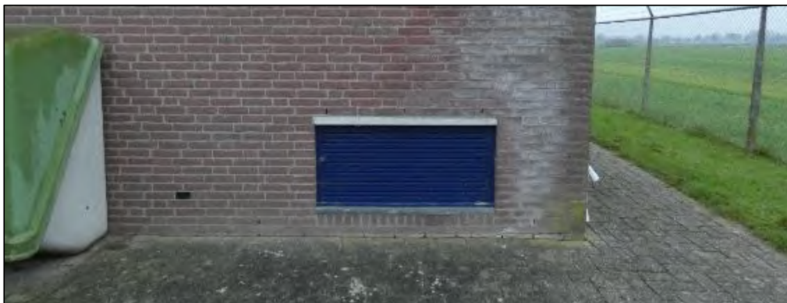
Figuur 10: De ventilatieroosters van het hoofdgebouw.
