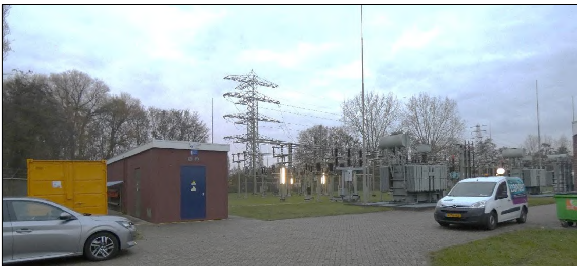
Figuur 3: Het bijgebouw en de schakeltuin.
