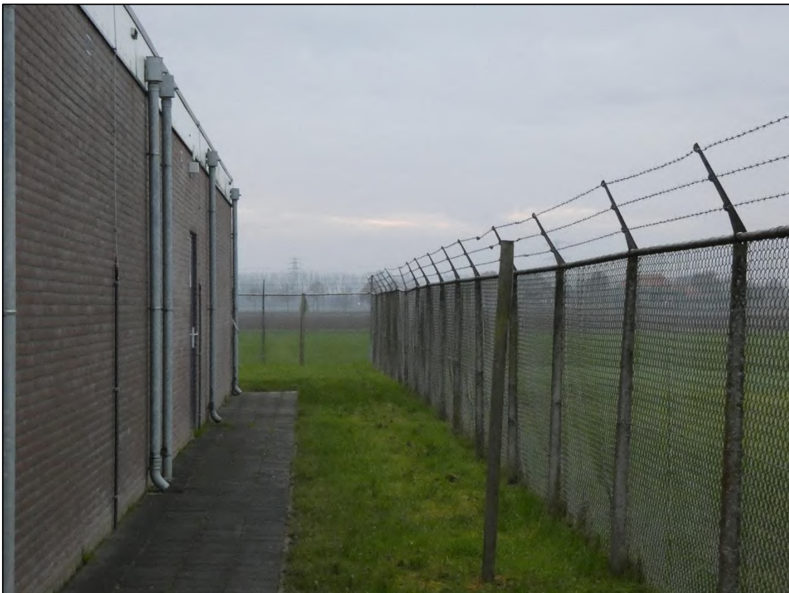
Figuur 12: Het tegelpad en grasveld rondom het hoofdgebouw.
