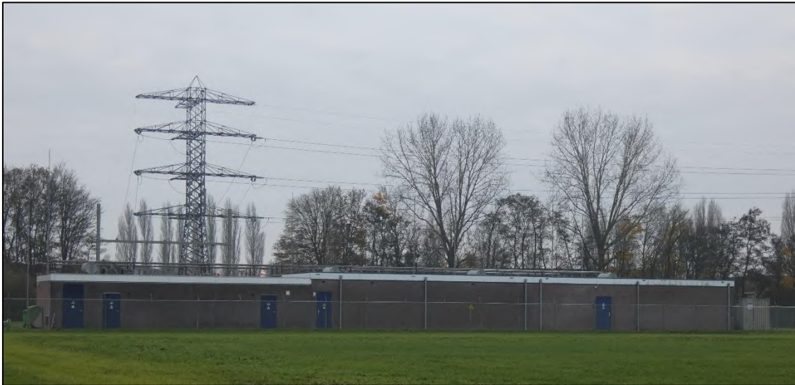
Figuur 2: Het hoofdgebouw.
