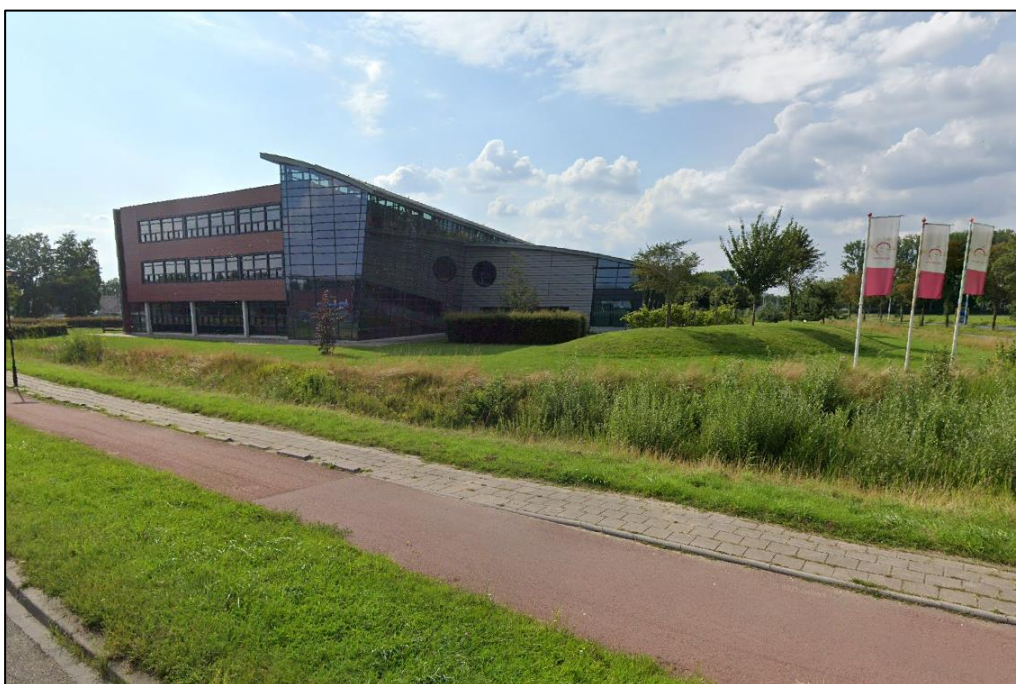
OBC Bommel gezien vanuit zuidoostelijke richting vanaf de Van Nispenlaan (bron: Google Streetview).
