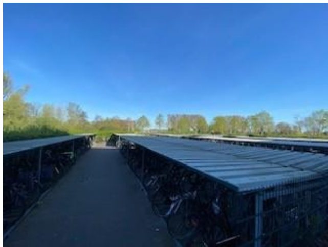
Figuur 5: Overzicht van fietsenstalling
