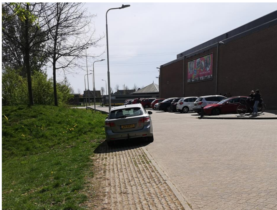
Figuur 15: In de middag gebruikt haalverkeer de grasbetontegels bij De Heister.
