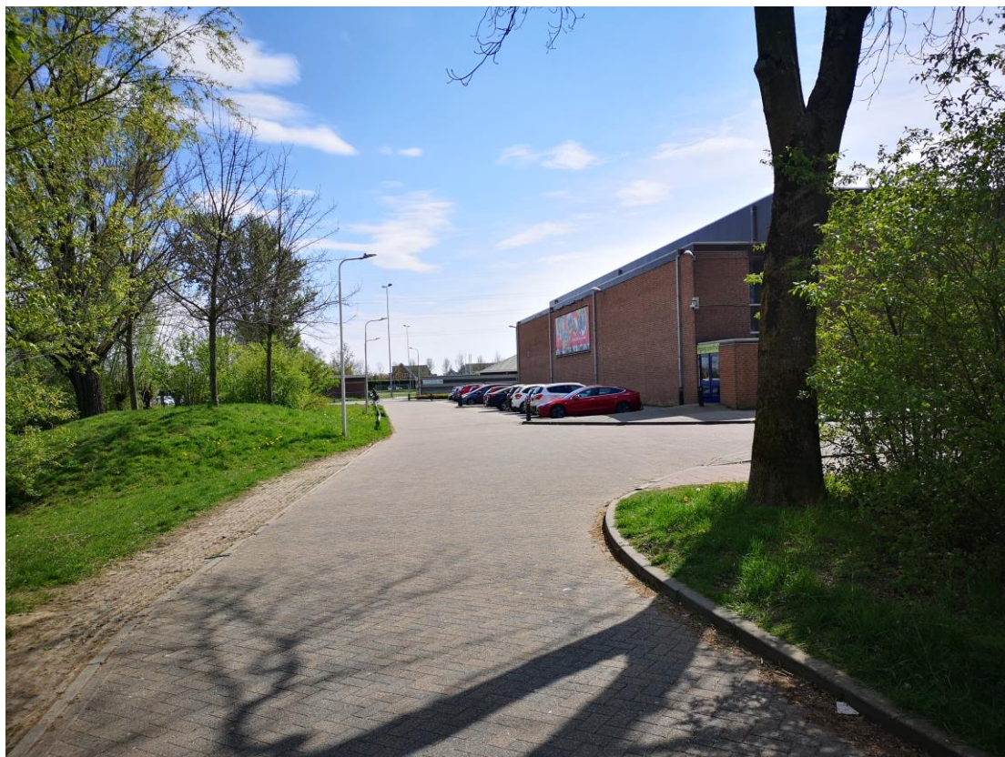
Figuur 17: Weggebruikers hebben slecht zicht richting rechts (uitgang fietsenstalling). Ook is de voorrangssituatie onduidelijk.
