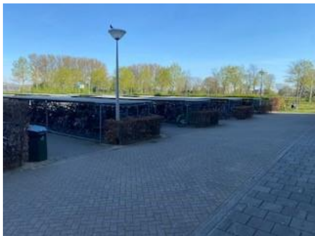
Figuur 4: Overzicht van fietsenstalling
