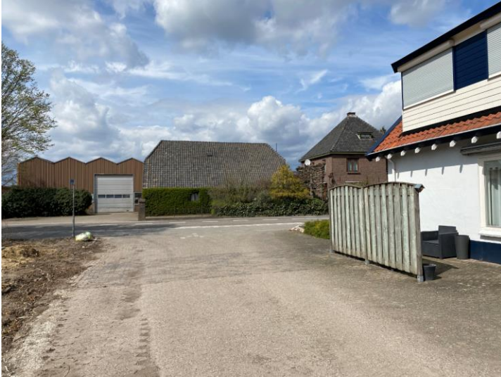
Bestaande aansluiting op de Karstraat
