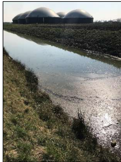
Foto 4. Watergang t.h.v. doorgebroken dam
