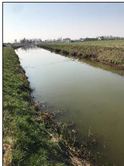
Foto 2. Doorvoerende watergang parallel aan de Azalealaan
