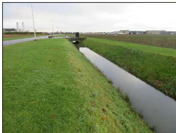
Foto 6. Sloop door het midden van het plangebied
