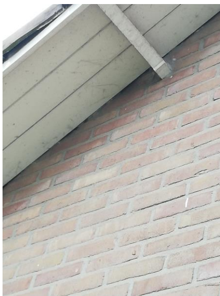
Figuur 4.5.1. De dakbetimmering op de lagere woningen kiert met de gevel. De gevelpannen liggen op een gladde lat.
