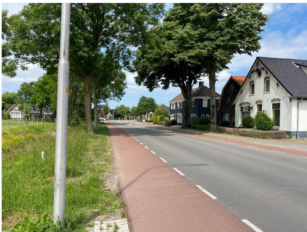
Wegprofiel Lodderhoeksestraat richting het noordwesten
