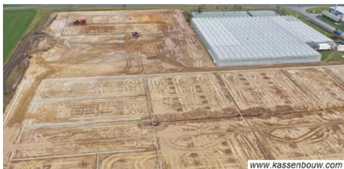
Voorbeeld bouwrijp maken voor kassenbouw
