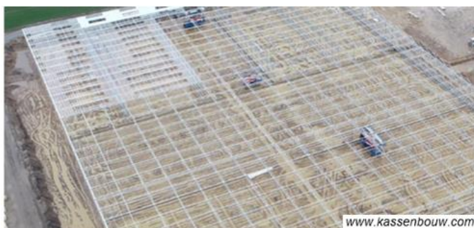
Voorbeeld oprichten staalconstructie
