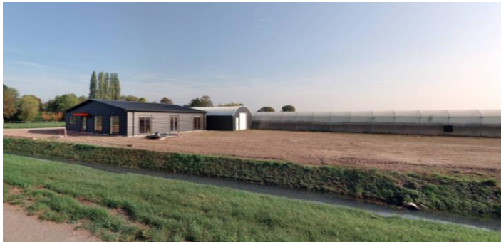
Foto plangebied gezien vanaf Clivia (feb 2020)
