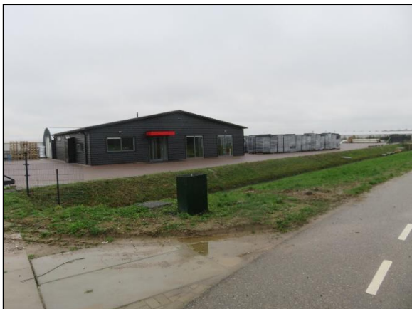
Foto 1. Bedrijfsgebouw aardbeikweker, noordwesten van het plangebied
