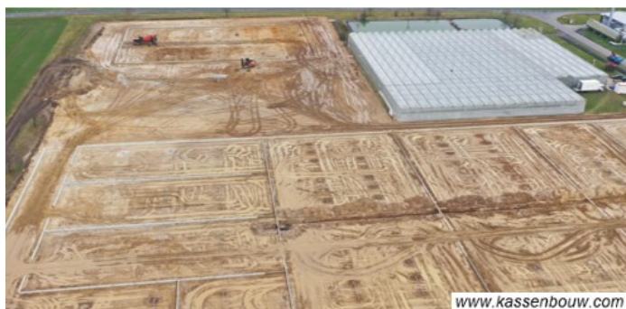
Voorbeeld bouwrijp maken voor kassenbouw
