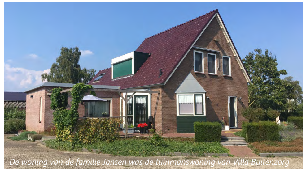
Op google streetview zijn de kassen achter Villa Buitenzorg nog zichtbaar
