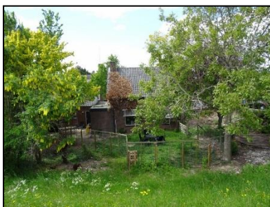
Figuur 6. Markt 24 gezien vanaf de tuinzijde.
