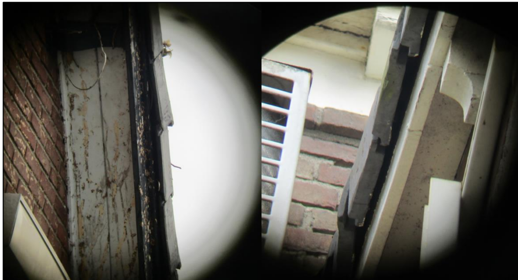
Figuur 4 Kierende dak-, kant- en nokpannen leiden mogelijk naar een geschikte rust- en verblijfplaats voor vleermuizen.
