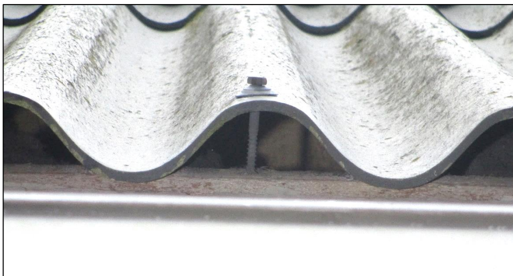
Figuur 4 Onder de golfplaten was geen kruipruimte voor vleermuizen aanwezig. De openingen leiden echter direct naar de binnenruimte van het voormalige bedrijfsgebouw.
