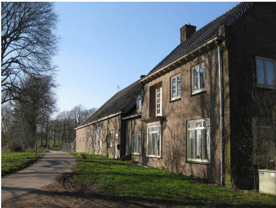
Het bestaande woonhuis met daarachter de grote schuren
