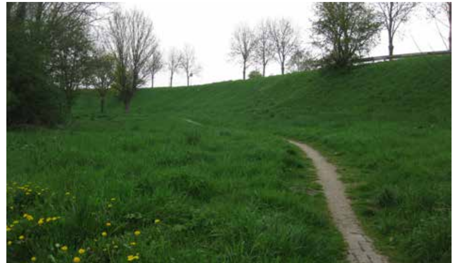
Afwezigheid van struweel op de dijk bij het Wiel van Klein Holthuizen
