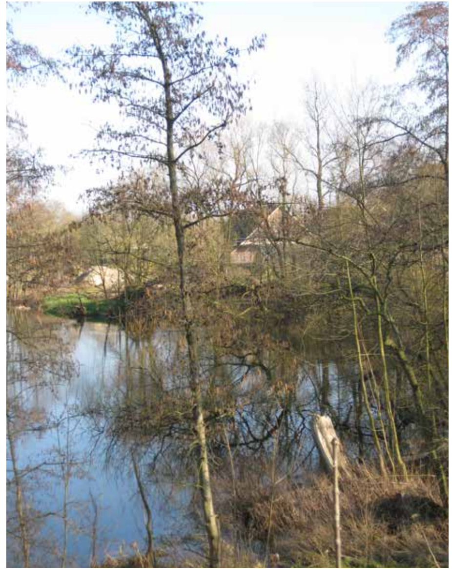
Verminderd zicht vanaf de dijk door elzenopschot, verwildering en verlanding
