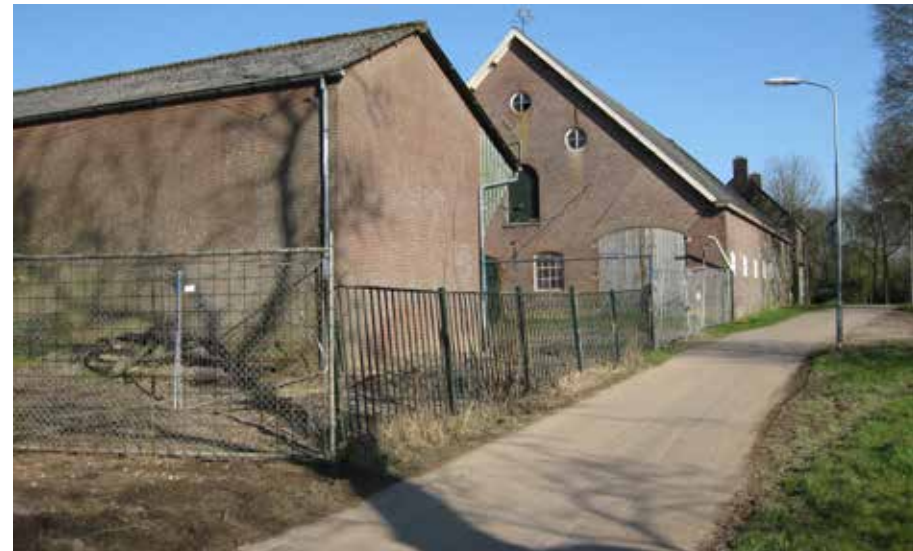
Het fiets- wandelpad direct langs de bebouwing
