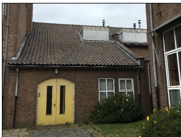
Foto 5. Zuidzijde van middenstuk van gebouw 1
