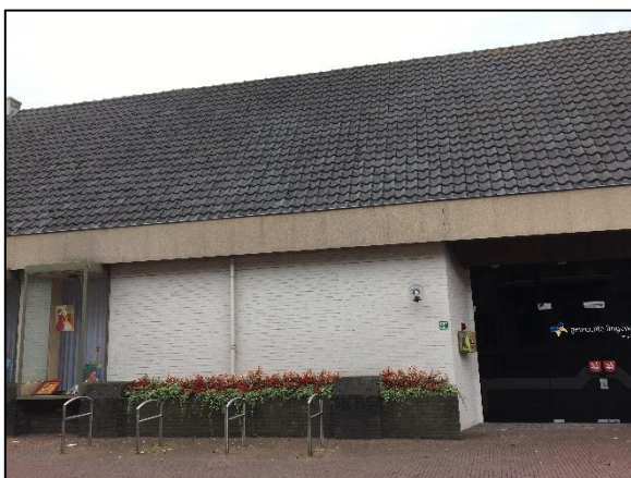
Foto 17. Oostzijde van gebouw 4
