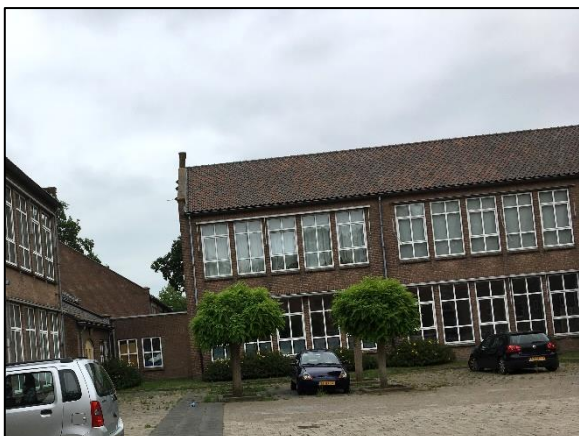
Foto 13. Westzijde van gebouw 2
