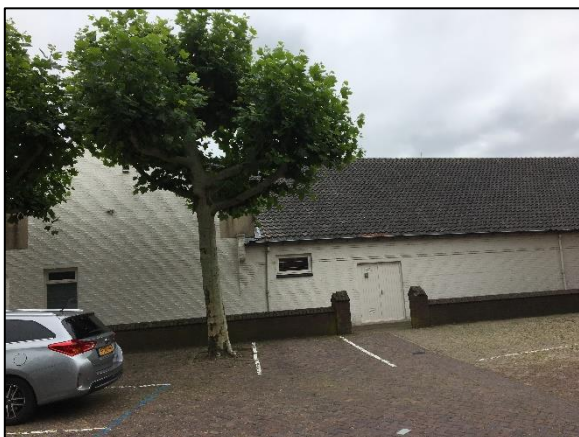
Foto 15. Noordzijde van gebouw 4
