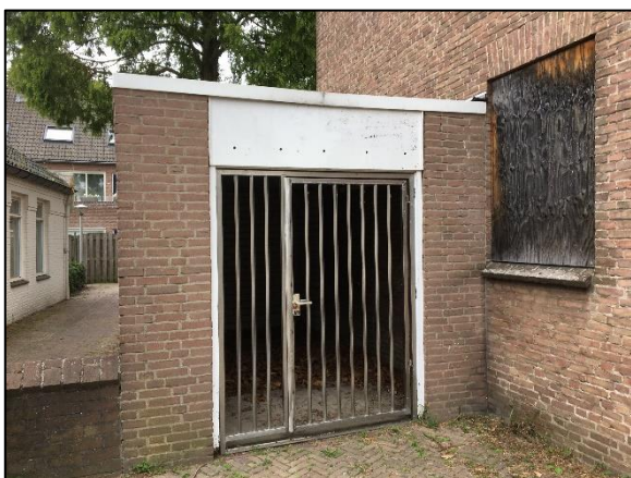
Foto 11. Aanbouw aan zuidzijde van gebouw 2
