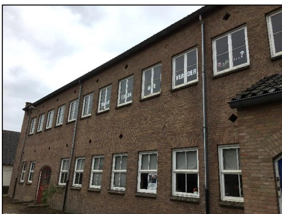
Foto 9. Oostzijde van gebouw 2
