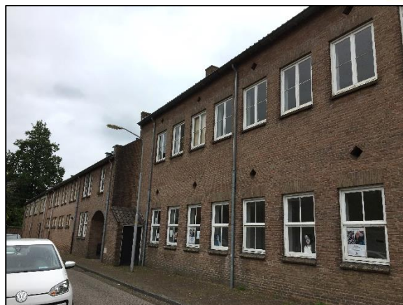
Foto 8. Noordzijde van gebouw 1
