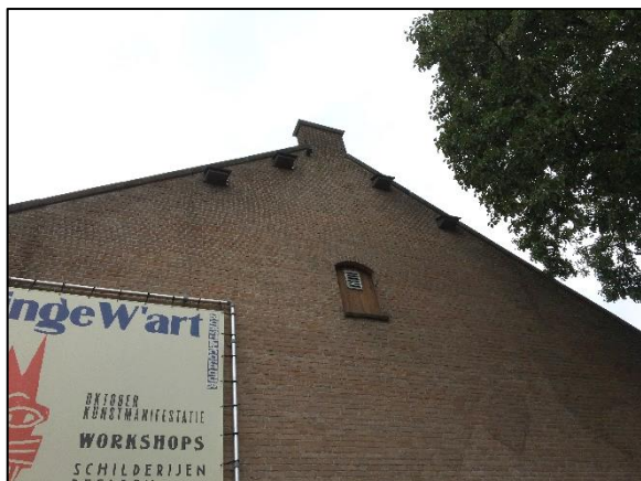
Foto 1. Oostzijde van gebouw 1
