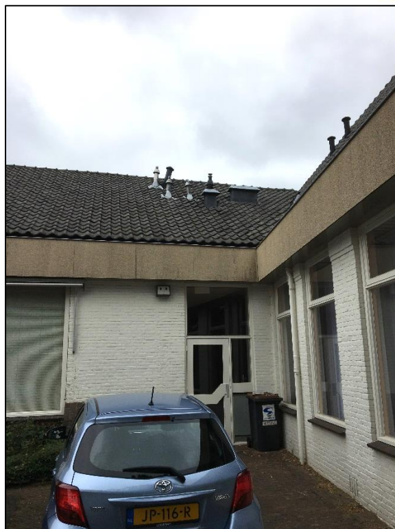
Foto 20. Zuidzijde vanuit binnenplaats gebouw 4
