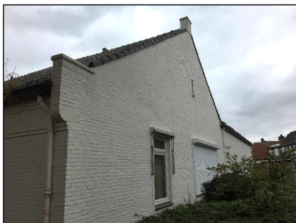
Foto 21. Oostzijde van gebouw 4
