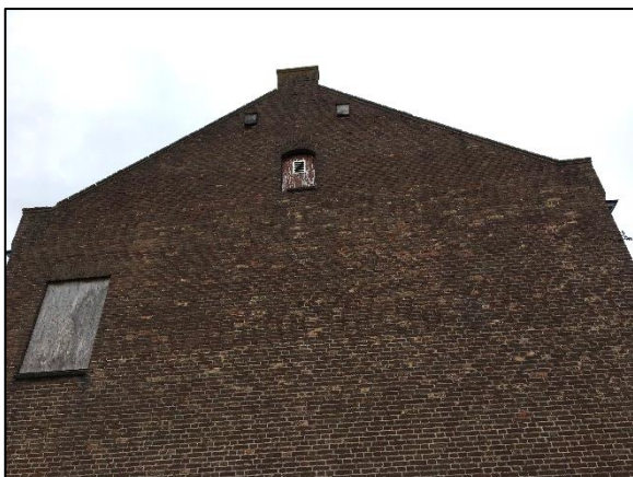
Foto 7. Westzijde van gebouw 1
