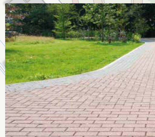
Betonklinker als inrit
