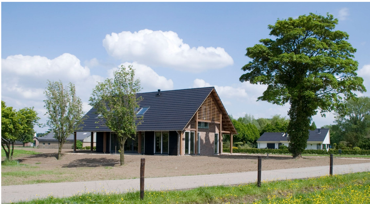
Schuurarchitectuur, doorlopend dakvlak, donkere en gedekte kleuren
