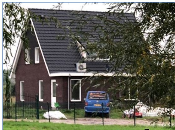
Nieuwe (in aanbouw zijnde) woningen aan Het Nevelveld.
