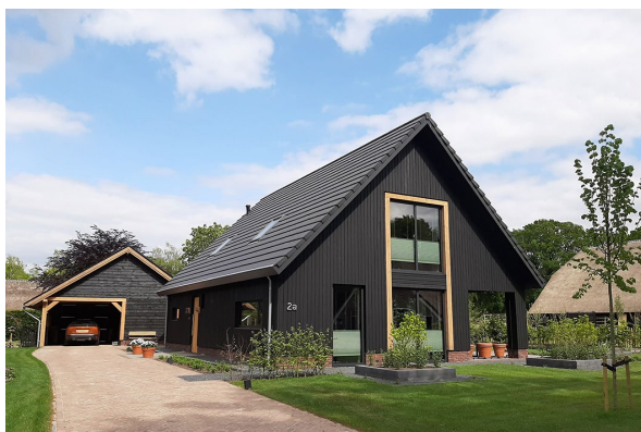
Ondergeschikt en meeontworpen bijgebouw.
