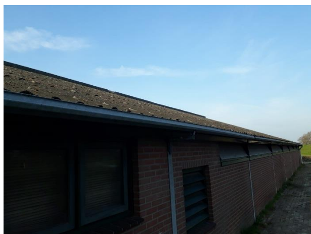
Dakgoot aan de noordzijde
