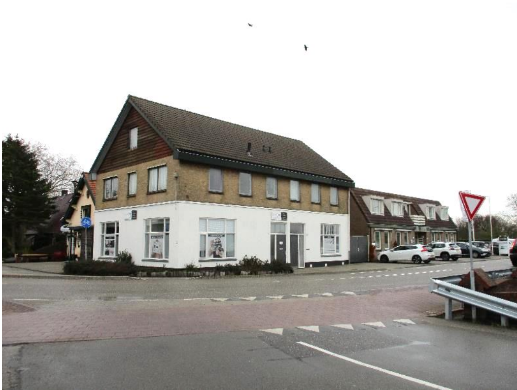
Figuur 1 De planlocatie is gelegen de lintbebouwing aan de Karstraat ong. te Huissen.
