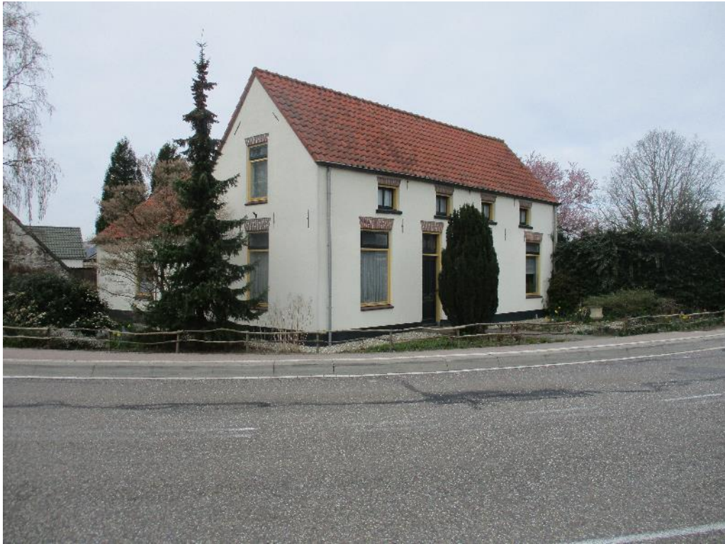
Figuur 5 Ten behoeve van de verbreding aan de zuidzijde van het perceel worden twee geschakelde woningen gesaneerd.
