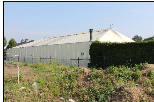
Foto 4. Te slopen kas
