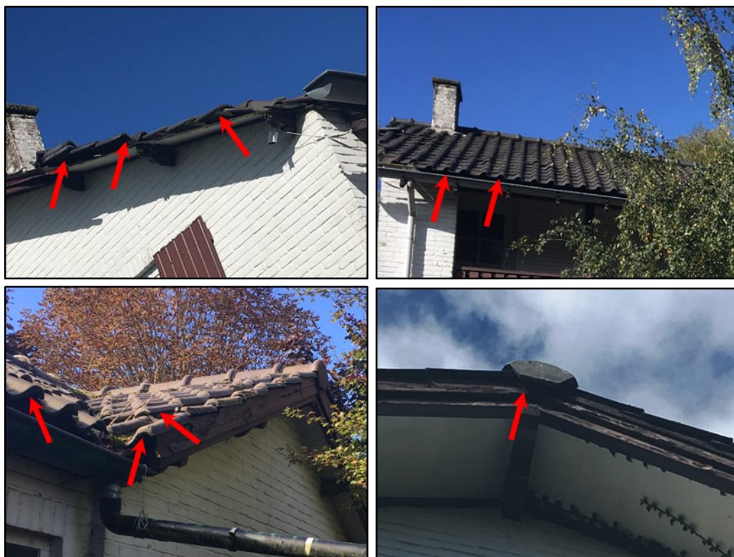
Figuur 2 De rode pijlen geven de openingen aan welke kunnen dienen als rust- en/of verblijfplaats van gebouwbewonende vleermuizen. Tevens zijn enkele van deze openingen geschikt voor gierzwaluw en huismus.
