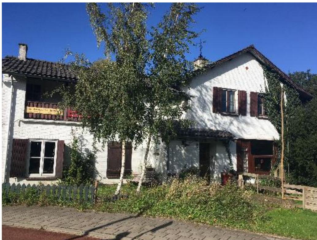
Figuur 1 De woning is opgetrokken uit gemetselde muren zonder spouwgangen en bekleed met een pannendak.
