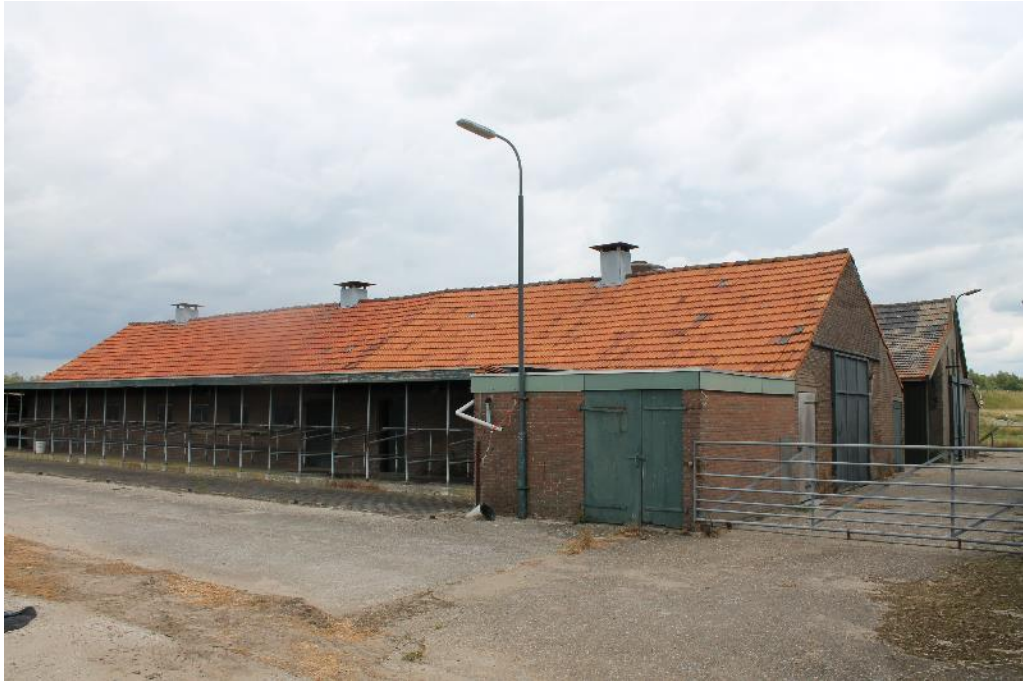
Figuur 1 De planlocatie is gelegen aan de Kerkstraat 29 te Doornenburg en bestaat uit drie te slopen schuren. Deze zijn een koeienstal, schapenstal en loods. Op het naastgelegen weiland wordt een nieuwe woning gerealiseerd en op de plek van de loods wordt nieuwe bebouwing gerealiseerd. De opstallen zijn opgetrokken uit gemetselde muren zonder spouw en hebben een zadeldak uit dakpannen of golfplaten.
