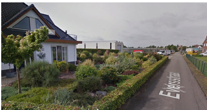
Figuur 2 Te saneren kassen aan de Eversstraat 2b. De bedrijfswoning blijft behouden (bron: GoogleStreetview)
