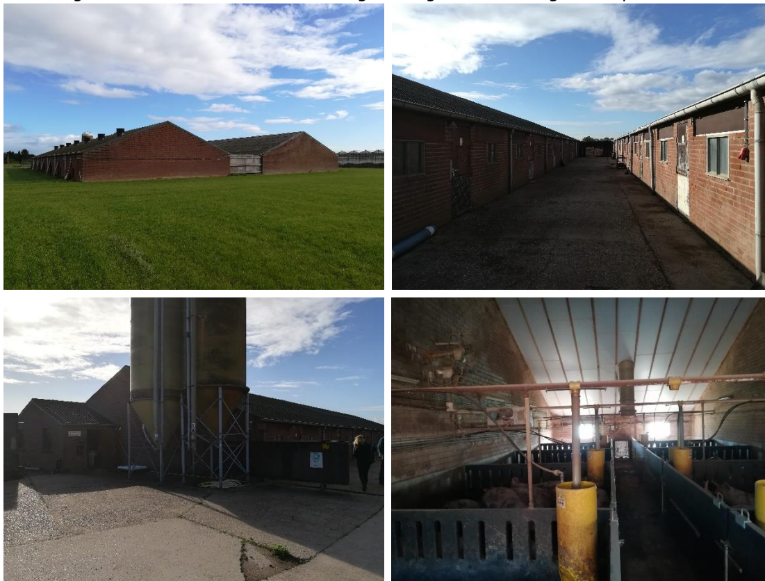
Indrukken van het plangebied aan de Zandvoortseweg 11 (foto's: Laneco).
