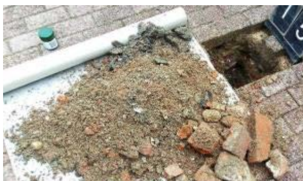
Foto 13: Fundatielaag (puin) gat 15.
