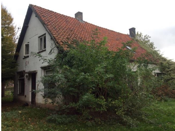
Figuur 8: Overzichtsfoto bebouwing
