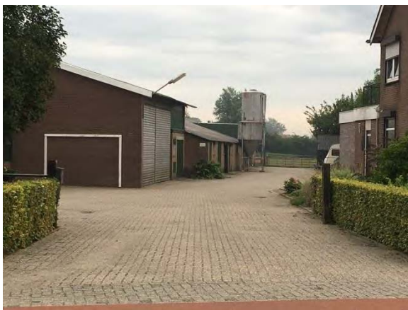
Figuur 13: Overzichtsfoto bebouwing
