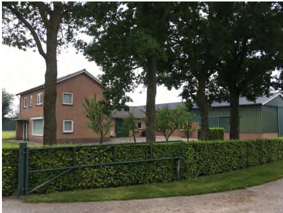
Figuur 12: Overzichtsfoto bebouwing
