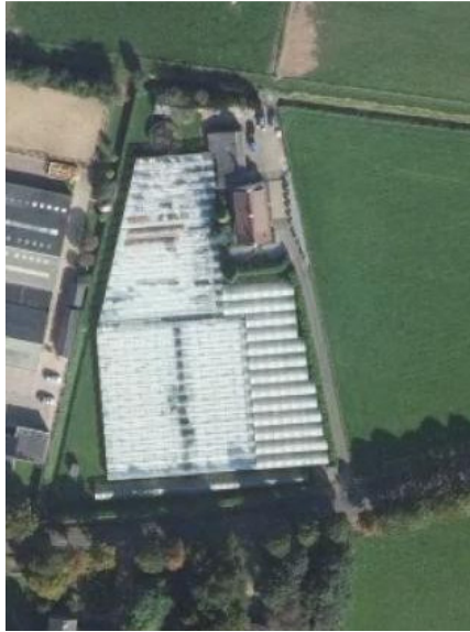
luchtfoto te slopen kassencomplex
