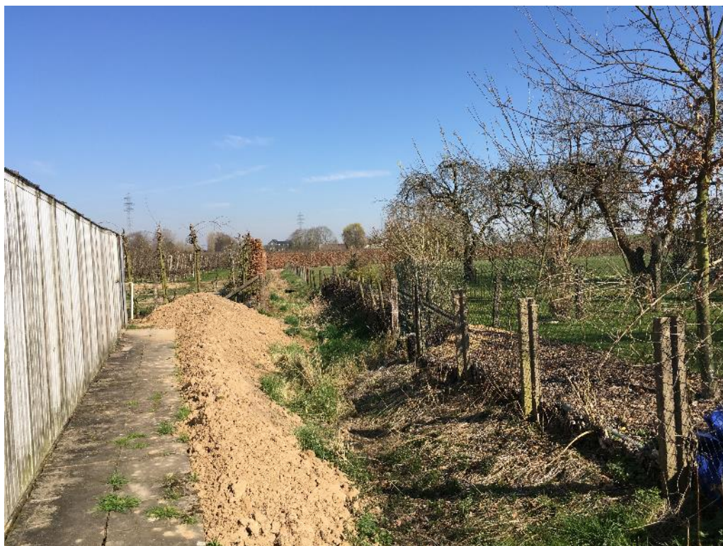
Figuur 2 De kassen worden gesloopt in het kader van de sloopmeterregeling. Ten oosten van de kassen is een niet watervoerende sloot gesitueerd.
