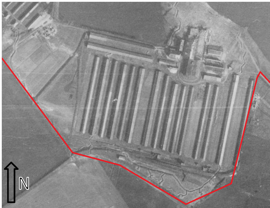
Afbeelding 26: Uitsnede van voorgaande afbeelding. Duidelijk zichtbaar zijn de loopgraven rondom en tussen de fabrieksgebouwen. (bron: Greenhouse Advies)
