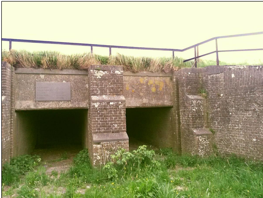
Figuur 3.1 Inlaat onder de weg Scherpekamp ten zuiden van het plangebied.
