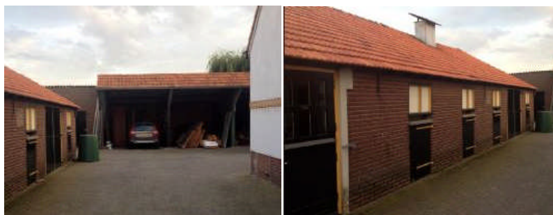
Figuur 4 Voormalige bedrijfswoning met karakteristieke bijgebouwen
