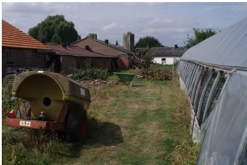
Locatie tussen kas en varkensschuur, waar bouw- en sloopaafval en asbestverdacht materiaal is aangetroffen
