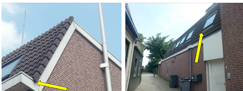
enkele voor gierzwaluw en huismus geschikte openingen in de daklaag van het pand waar de Zee-man is gevestigd
