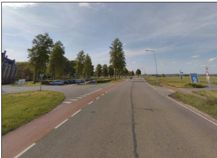
Figuur 3.4: Stadsdam Huissen, nabij de aansluiting met de Arnhemsepoort (linker aansluiting)
