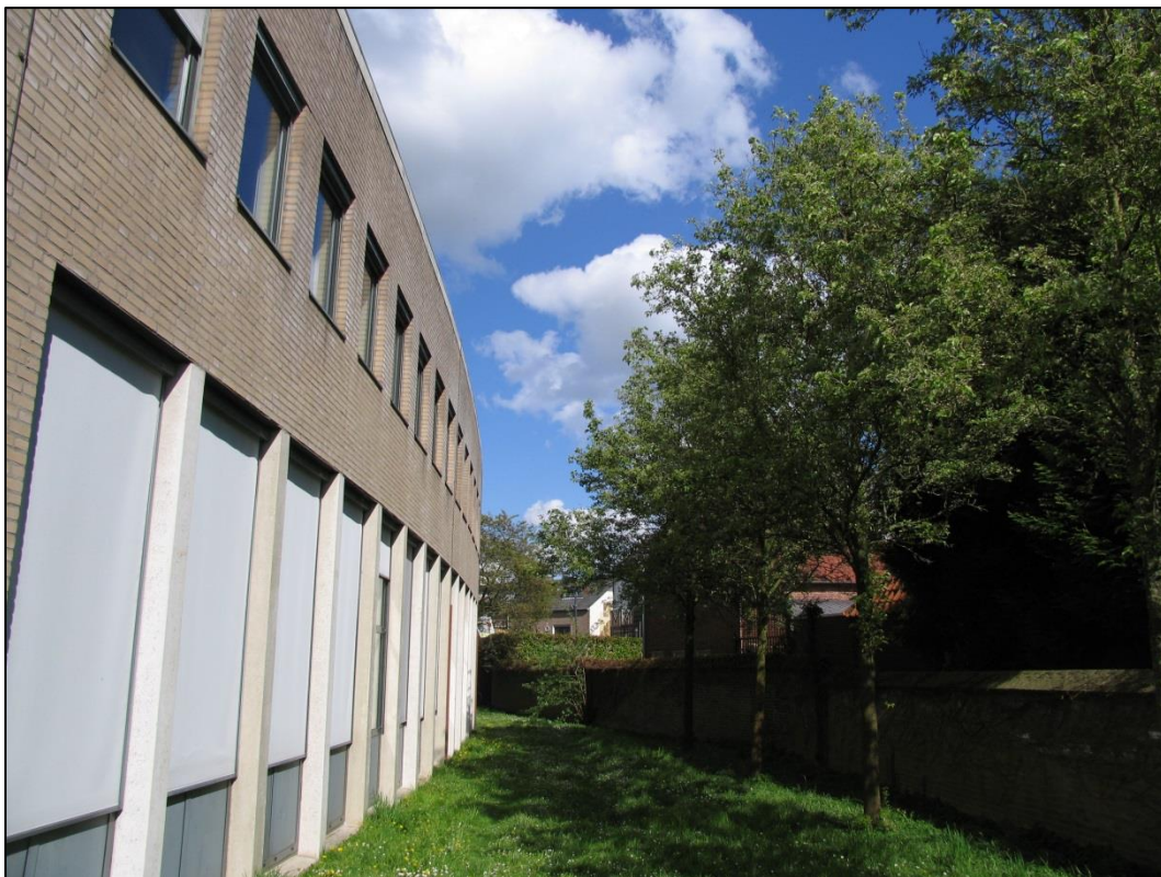
Boven: dak van de oostvleugel. Beide kanten van de daken van zowel de oost- als de westvleugel zullen over de gehele lengte dakkapellen krijgen. Onder: de zuidvleugel zal gezien de bouwstijl die niet bij de rest van de bebouwing past geheel worden gesloopt. Passende bebouwing zal terug worden gebouwd.
