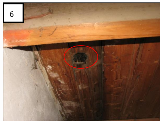
Afbeelding 5. Open stootvoegen aan de noordzijde van de bebouwing (5.1), buitenkant van kapel (5.2), zuidgevel met open stootvoegen (5.3/5.4) en holtes en kieren in het oostelijke deel van de zolder (5.5/5.6). De stootvoegen zijn op meerdere plaatsen ruim genoeg voor kleine vleermuissoorten om er doorheen te kruipen.
