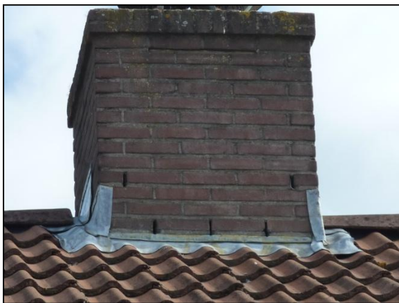
Figuur 14. Open stootvoegen geven vleermuizen toegang tot potentiële verblijfplaatsen.
