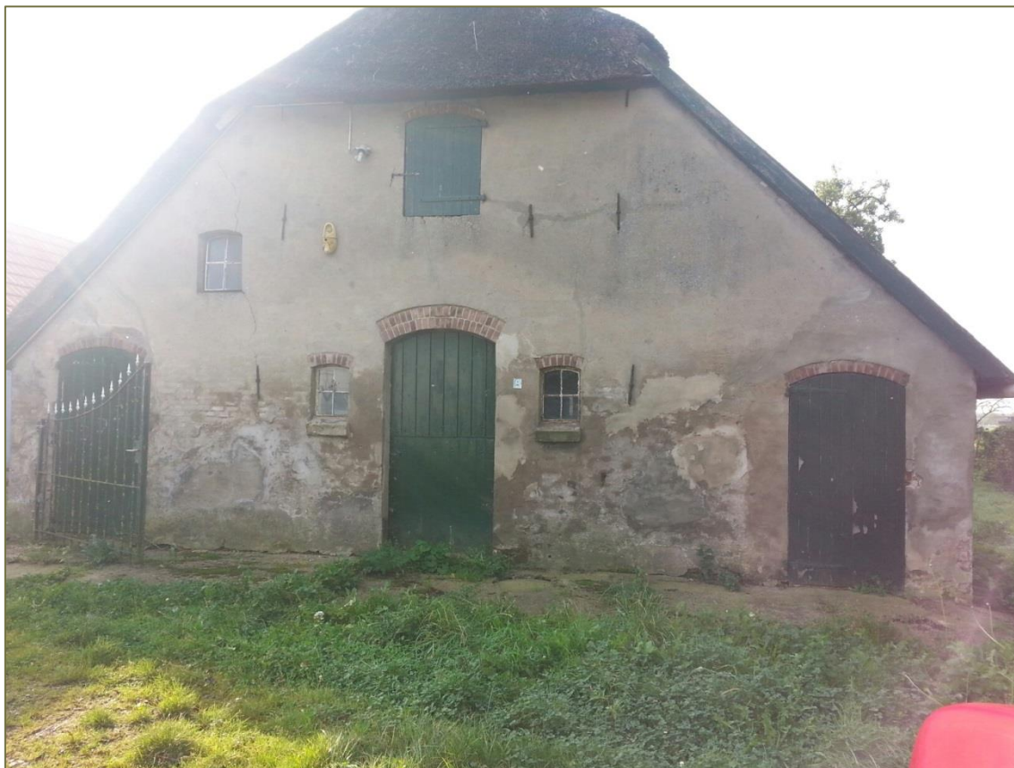
Figuur 10: Boerderij uit ca. 1920. Dit gebouw wordt gesloopt
