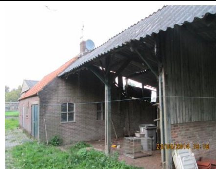
Foto 5: Detail veldschuur met aangebouwde stenen schuur.
