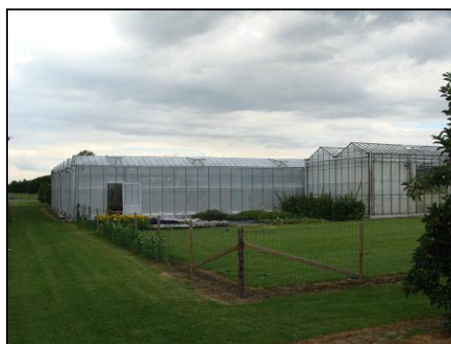
Foto 2. Te slopen kas
