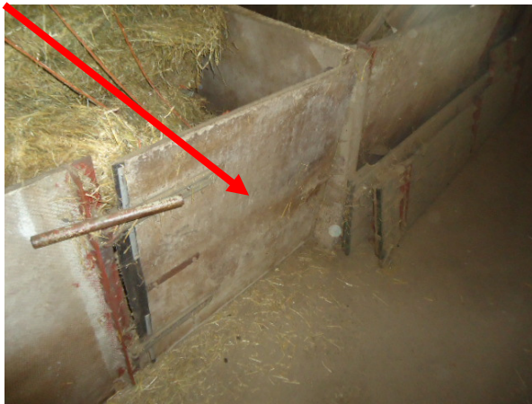
Afbeelding 9: Binnenzijde schuur A/Schotten
