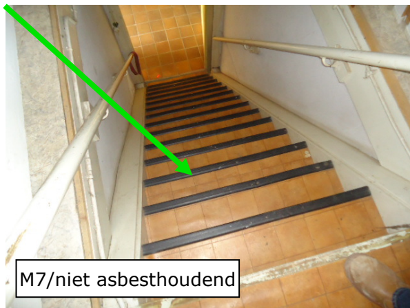
Afbeelding 25: Binnenzijde woonhuis/Vloerzeil
