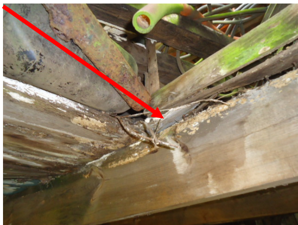
Afbeelding 23: Binnenzijde schuur C/Restanten vlakke plaat
