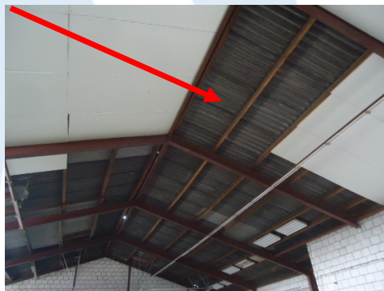
Afbeelding 4: Buitenzijde loods/Golfplaten op het dak
