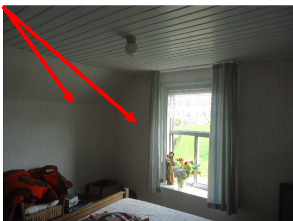
Afbeelding 23: Binnenzijde woonhuis/Wandbeplating op verdieping
