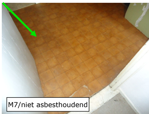
Afbeelding 24: Binnenzijde woonhuis/Vloerzeil
