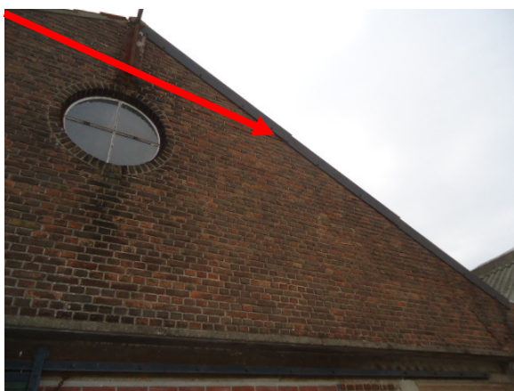
Afbeelding 11: Buitenzijde loods B/Windveren
