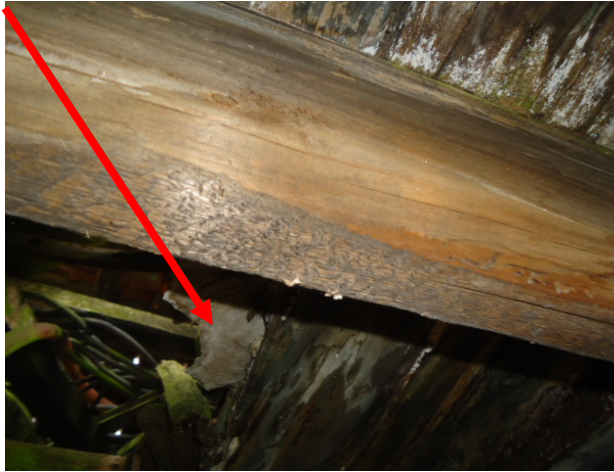
Afbeelding 25: Binnenzijde schuur C/Restanten vlakke plaat
