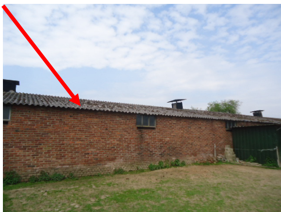
Afbeelding 3: Buitenzijde schuur A/Golfplaten op het dak
