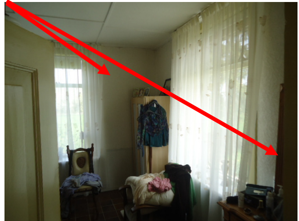
Afbeelding 28: Binnenzijde woonhuis/Wandbeplating slaapkamer
