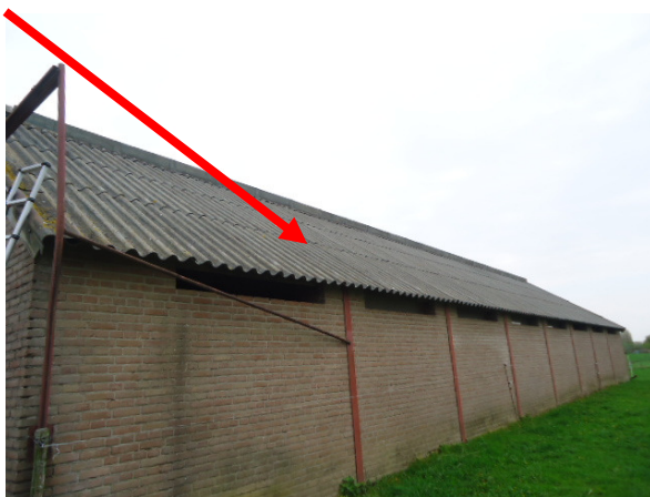
Afbeelding 5: Buitenzijde loods A/Golfplaten op het dak
