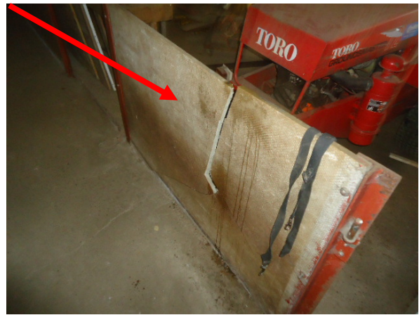
Afbeelding 8: Binnenzijde schuur A/Schotten
