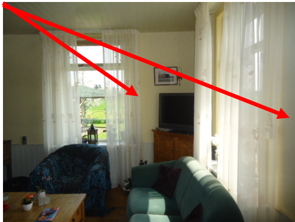
Afbeelding 27: Binnenzijde woonhuis/Wandbeplating in woonkamer
