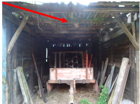
Afbeelding 20: Binnenzijde schuur C/Restanten vlakke plaat
