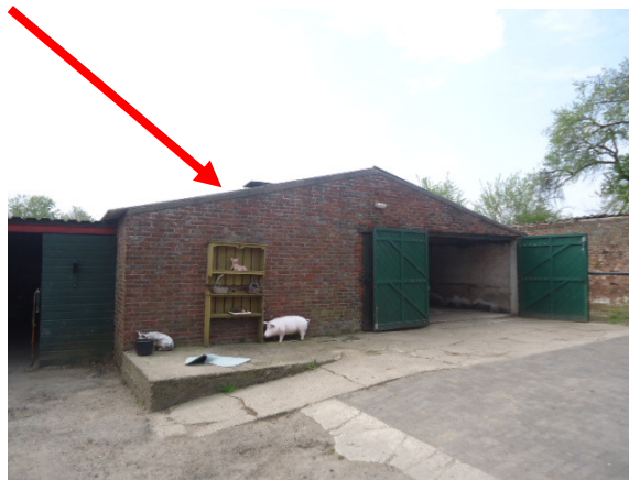
Afbeelding 2: Buitenzijde schuur A/Golfplaten op het dak
