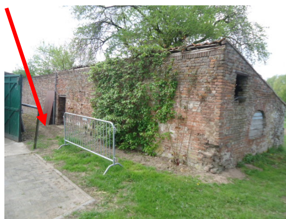
Afbeelding 14: Buitenzijde schuur B/Losse plaat
