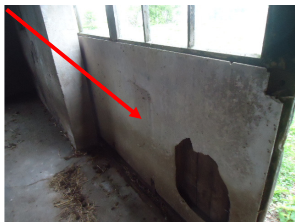
Afbeelding 12: Buitenzijde loods B/Beplating op schuifdeur
