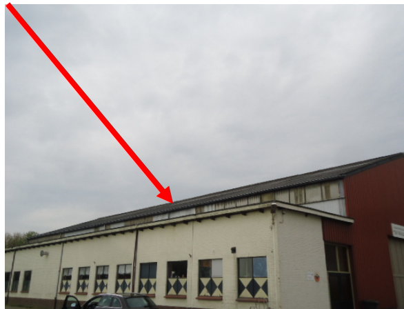
Afbeelding 2: Buitenzijde manege/Golfplaten op het dak
