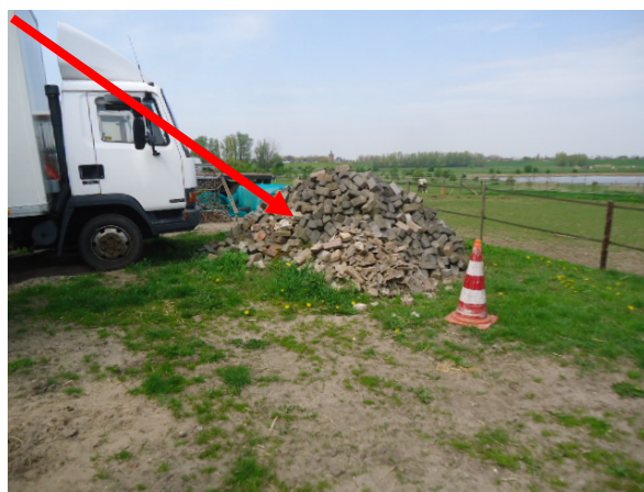
Afbeelding 20: Berg puin/Restanten asbestcement
