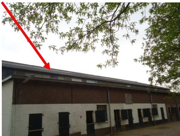
Afbeelding 3: Buitenzijde manege/Golfplaten op het dak
