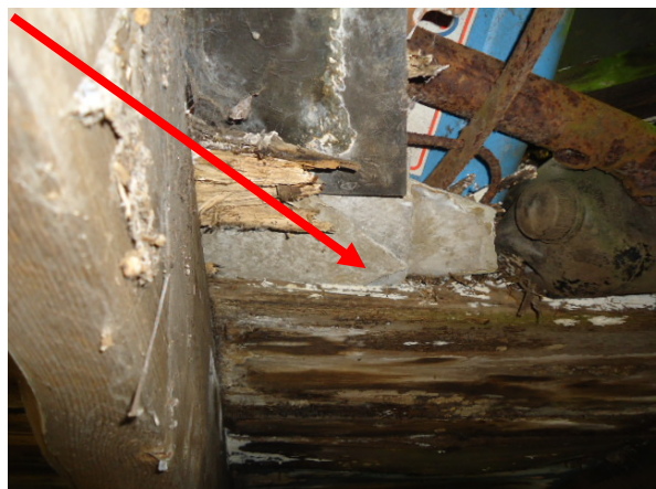
Afbeelding 24: Binnenzijde schuur C/Restanten vlakke plaat
