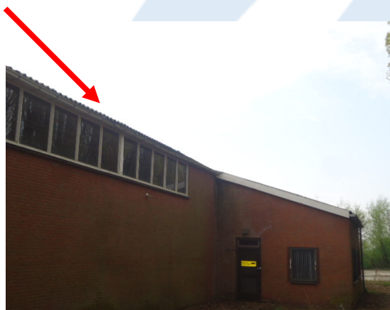
Afbeelding 3: Buitenzijde loods/Golfplaten op het dak
