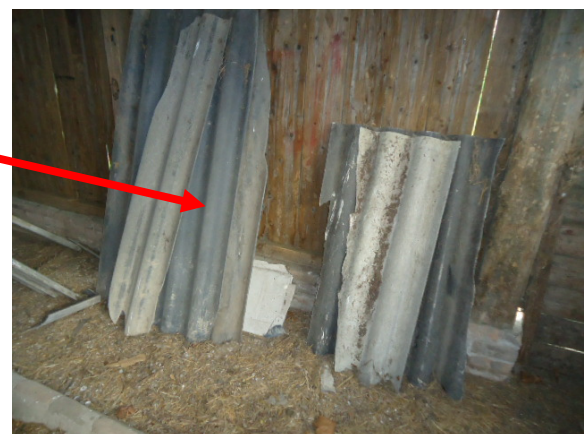
Afbeelding 18: Binnenzijde schuur C/Losse golfplaten/nokstukken
