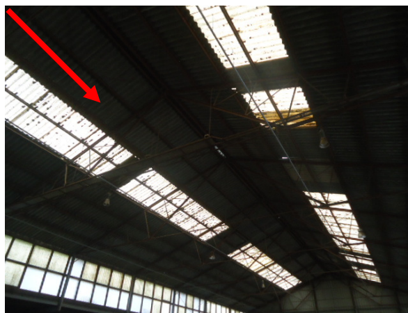
Afbeelding 4: Buitenzijde manege/Golfplaten op het dak
