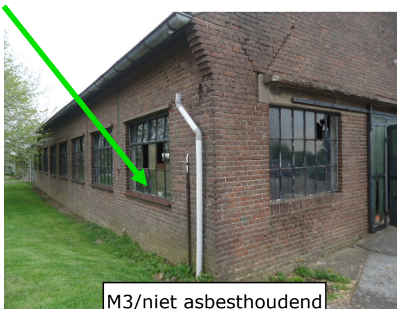
Afbeelding 9: Buitenzijde loods B/Beglazingskit stalen ramen
