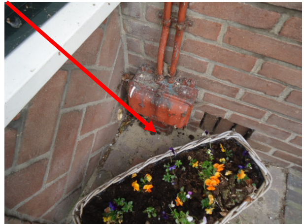
Afbeelding 2: Buitenzijde woonhuis/Koord in kabeldoorvoer
