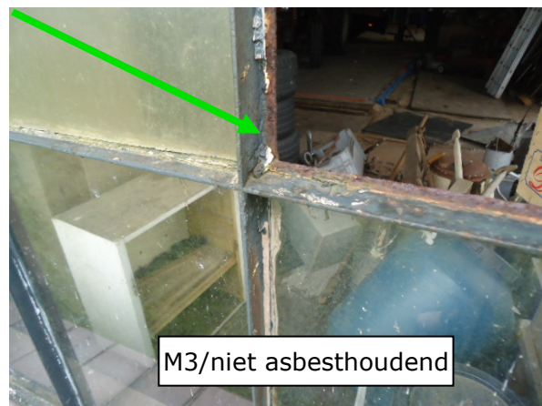
Afbeelding 10: Buitenzijde loods B/Beglazingskit stalen ramen
