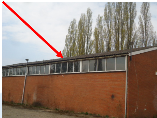
Afbeelding 2: Buitenzijde loods/Golfplaten op het dak
