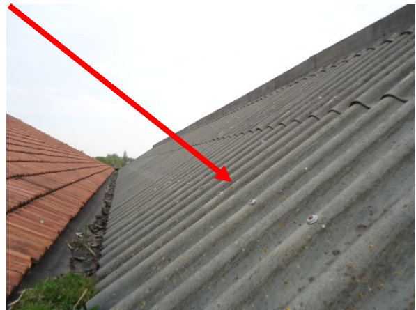
Afbeelding 4: Buitenzijde loods A/Golfplaten op het dak
