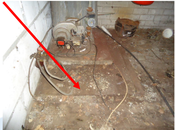
Afbeelding 8: Binnenzijde loods/Beplating onder cv
