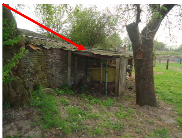
Afbeelding 17: Buitenzijde schuur B/Golfplaten op het afdak
