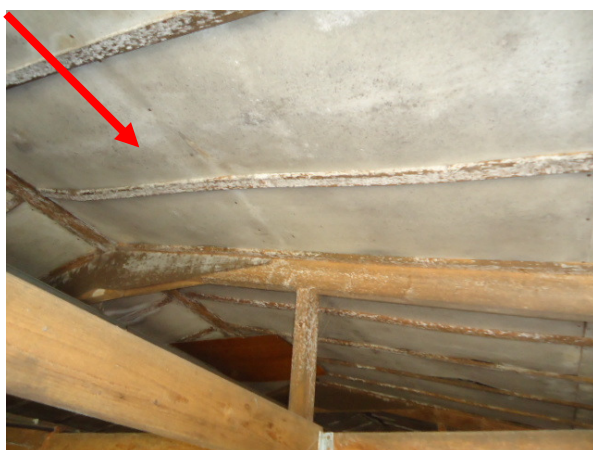
Afbeelding 5: Binnenzijde schuur A/Aftimmering onderzijde dak
