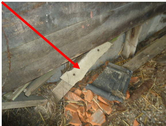
Afbeelding 21: Binnenzijde schuur C/Restanten vlakke plaat
