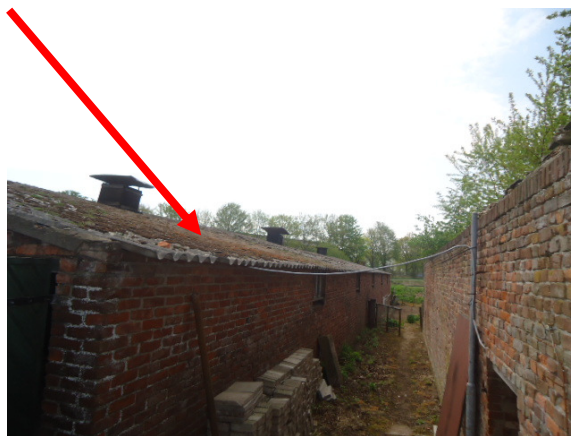
Afbeelding 4: Buitenzijde schuur A/Golfplaten op het dak
