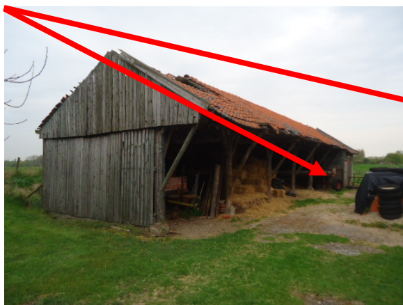
Afbeelding 17: Binnenzijde schuur C/Losse golfplaten/nokstukken
