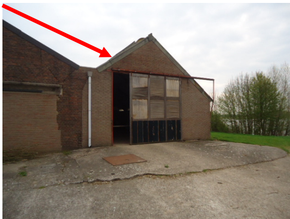
Afbeelding 3: Buitenzijde loods A/Golfplaten op het dak
