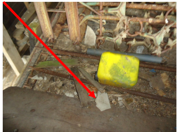
Afbeelding 22: Binnenzijde schuur C/Restanten vlakke plaat
