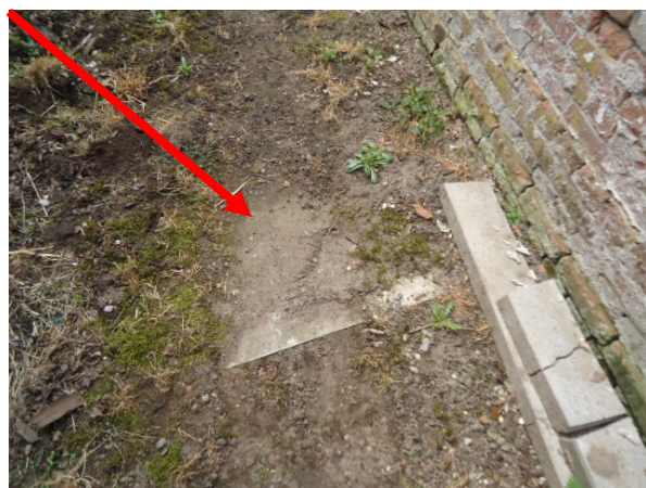
Afbeelding 15: Buitenzijde schuur B/Losse plaat
