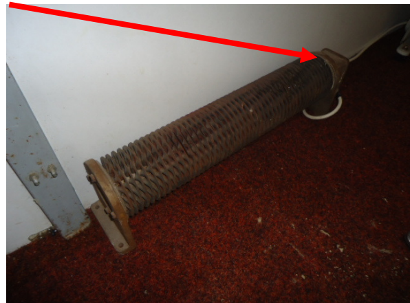
Afbeelding 12: Binnenzijde manege/Pakkingringen inclusief in oude elektrakachel
