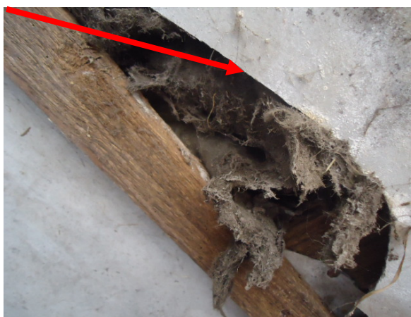
Afbeelding 6: Binnenzijde schuur A/Aftimmering onderzijde dak
