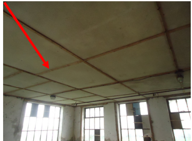
Afbeelding 16: Binnenzijde loods B/Plafondbeplating stal
