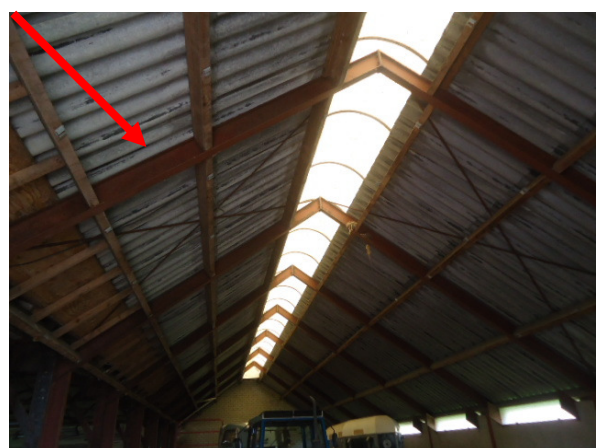
Afbeelding 6: Buitenzijde loods A/Golfplaten op het dak
