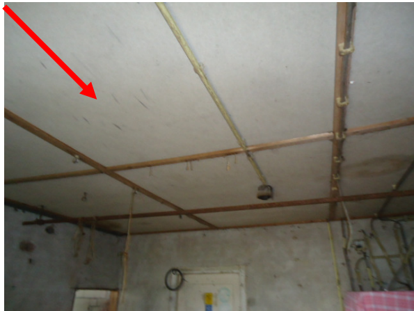
Afbeelding 13: Binnenzijde loods B/Plafondbeplating melkkamer
