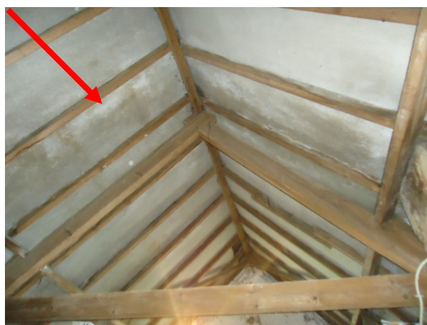
Afbeelding 22: Buitenzijde woonhuis/Dakbeschot onder de pannen
