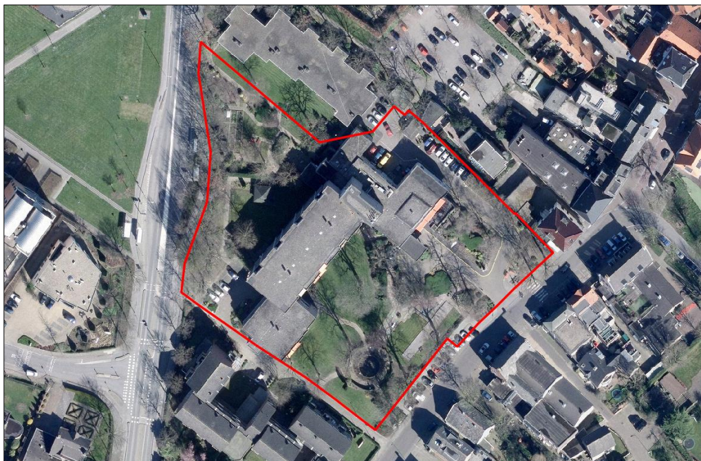
Ligging plangebied met de te slopen bebouwing.
