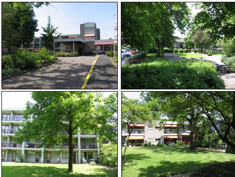
Linksboven: foto van het te slopen centrale gebouw, gezien vanuit de oprit aan de Helmichstraat naar het noordwesten. Rechtsboven: voortuin gezien vanuit dezelfde oprit naar het zuidwesten. Linksonder: centrale gebouw gezien vanuit de achtertuin richting het zuidoosten. Rechtsonder: aanleunwoningen die behouden blijven gezien vanuit dezelfde achtertuin naar het noordoosten
