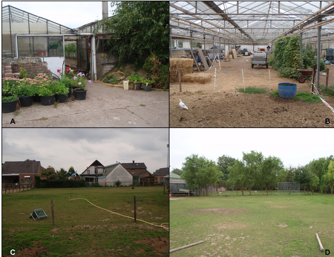
Figuur 6. Enkele overzichtsfoto's van het plangebied: A. Vooraanzicht van een deel van de kassen vanaf de Hulhuizerstraat; B. Een van de kassen aan de binnenkant; C. Het achterterrein gezien in westelijke richting; D. Het achterterrein gezien in oostelijke richting.
